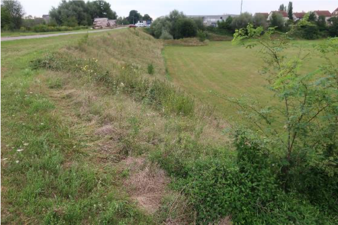
Abbildung 2.6: Nördliche Böschung der «Schafgrube Schalm»
