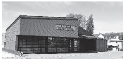
Abb 8: Feuerwehrdepot mit sanierter Fassade
