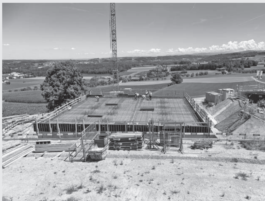
Neubau Reservoir Wertbühl
