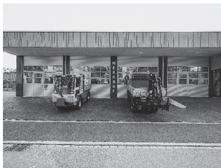
Abb 1: Eingang neuer Werkhof
