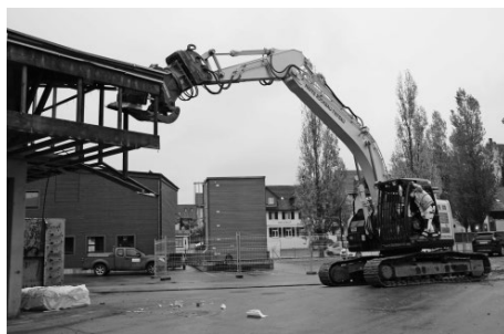
Abb 1: Startschuss des Abbruchs [www.neueranzeiger.ch]
