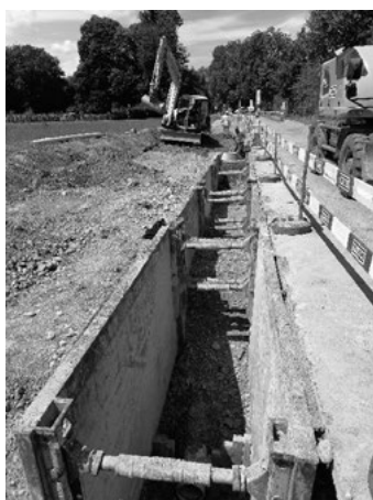
Abb 3: Sanierung Kanalstrasse, Bürglen
